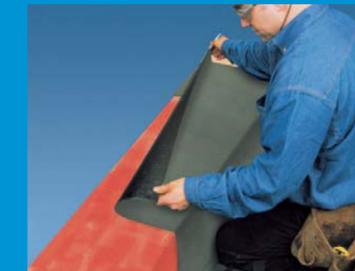
4 **Installer** la sous-couche autocollante des relevés sur les surfaces préalablement apprêtées.
