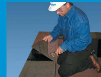
7 **Installer** la couche de finition des relevés sur une surface entièrement recouverte d'adhésif.
