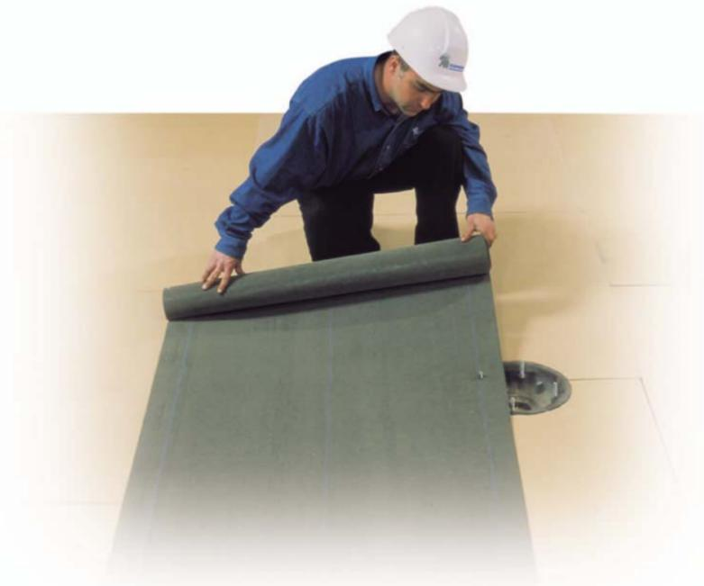
**Membranes de bitume modifié SBS haute performance installées sans chalumeau ni asphalte**
