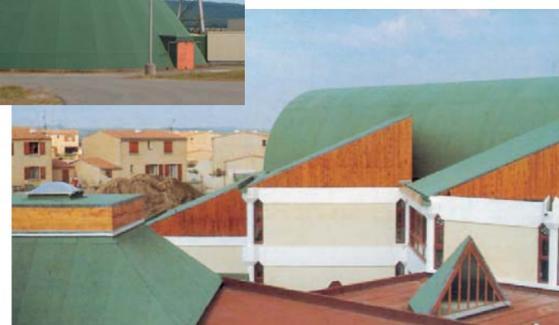
UNILAY est plus léger que les systèmes de toiture multicouche traditionnels : 7,5 kg/m<sup>2</sup> comparativement à 30 kg/m<sup>2</sup>\*\*. Grâce à son système de fixations mécaniques efficace, même les toits en pente ne vous laisseront plus tomber.
