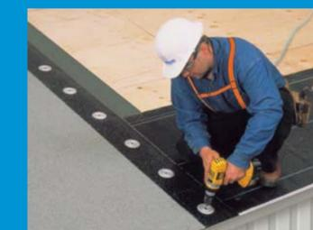
7 Fixer mécaniquement les bordures de la membrane selon les exigences du Manuel technique de Soprema.
