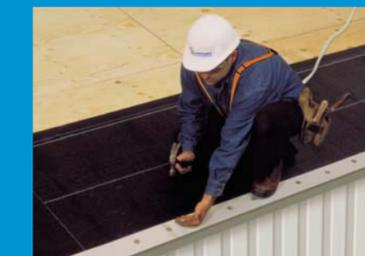
2 Appliquer la sous-couche des relevés et renforts directement sur la surface apprêtée, le long des périmètres et des parapets.
