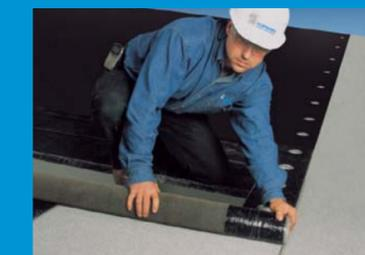
4 Dérouler la membrane de finition à sec, au moins 20 minutes avant la pose. Bien l'aligner et la réenrouler.
