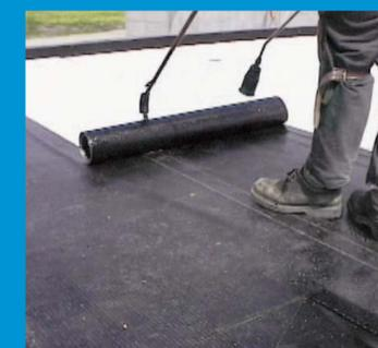
**4 Souder au chalumeau** la couche de finition sur la sous-couche (ou installer avec adhésif).
