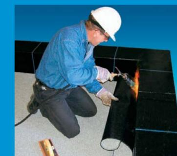
**5 Installer la couche de finition** des relevés par soudure au chalumeau (ou installer avec adhésif).
